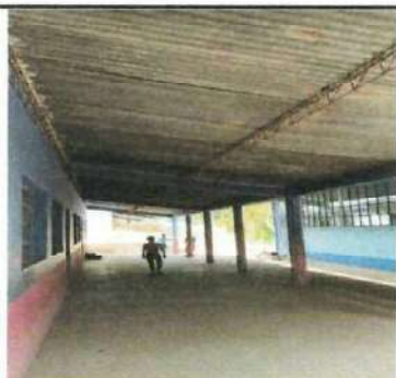
Foto 5: Se observa la necesidad de sustituir la estructura de techo
