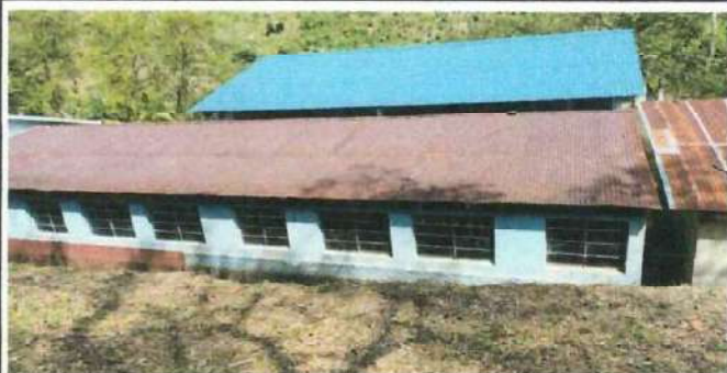
Foto 3: Se observa la necesidad de sustituir la cubierta de las laminas
